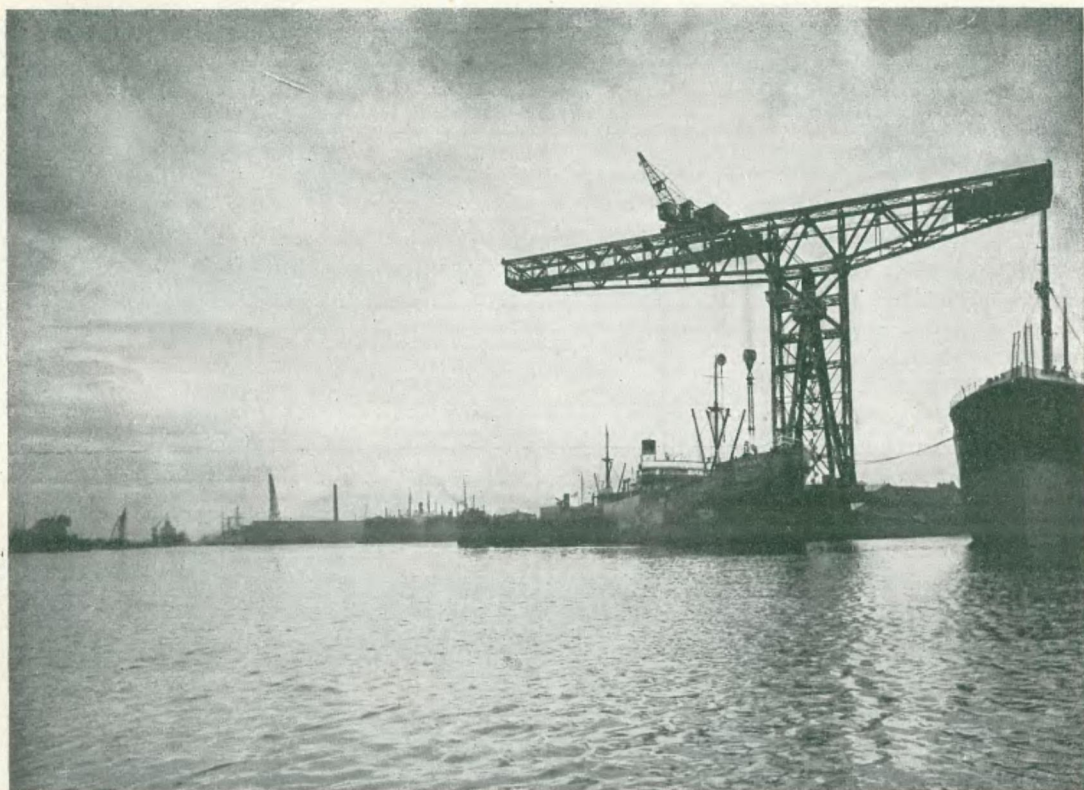
WIDOK OGÓLNY TERENÓW STOCZNI GDAŃSKICH
