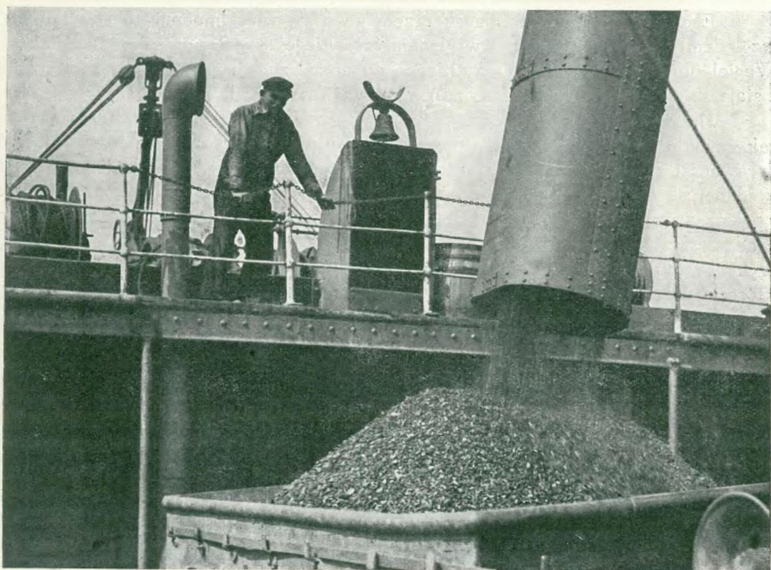
KOŃCOWY MOMENT PRACY TAŚMOWYCH URZĄDZEŃ PRZEŁADUNKOWYCH DLA WĘGLA
