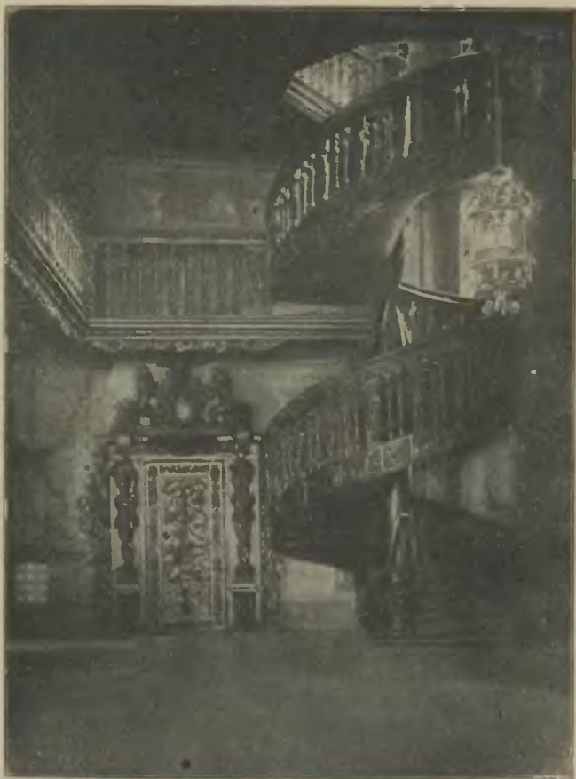
Geschnitzte Tür und Wendeltreppe im Rathaus
